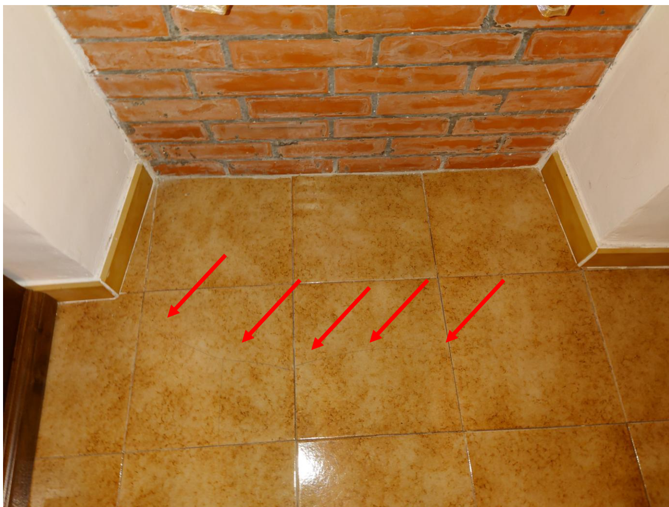
34. Camera, dettaglio fessurazione pavimento – piano primo (07/12/2023)
